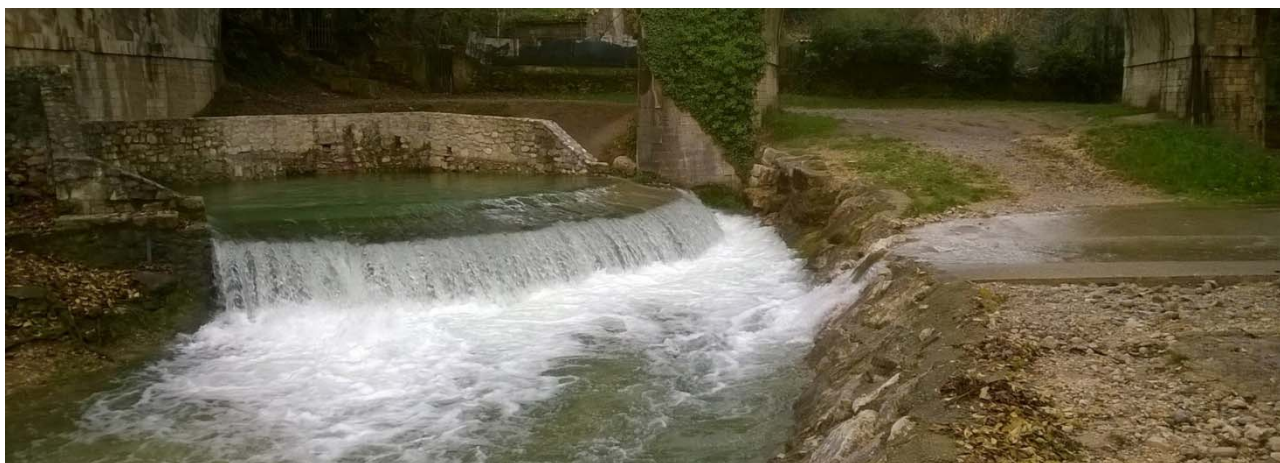
Bourg Saint Andéol (07) Le Goul du Pont en crue en Novembre 2014 (photo : MC)
