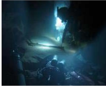
Perçage des trous de fixation de la cloche.
