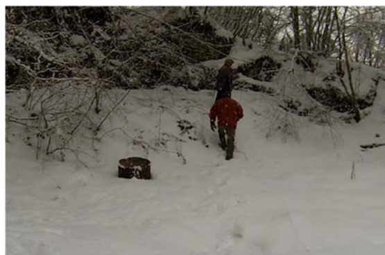
Installation des antennes
